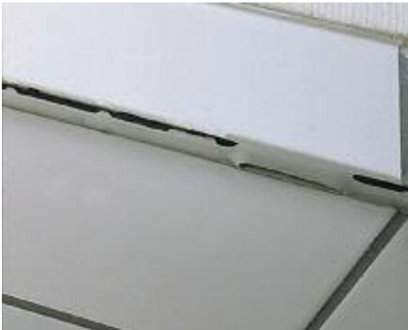
**Verursacht werden die porösen Stellen, Risse oder sogar Abtrennungen der Fugen** einerseits durch Verwölbungen im Estrich während dessen Trockenzeit, andererseits auch durch Temperaturschwankungen, Luftfeuchtigkeit und mechanische Belastungen an den Übergängen zur Wand.
