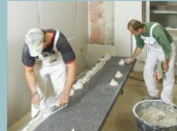
Die Verbundplatten werden mittels Batzentechnik an den Wänden angebracht
