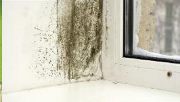
**Beim Bau eines 100 m<sup>2</sup> großen Hauses werden rund 15.000 l Wasser für Beton, Mörtel, Estrich, Putz und Farbe verwendet. Diese Menge kann während der Bauzeit nicht vollständig verdunsten und bleibt in den Räumen zurück.**
