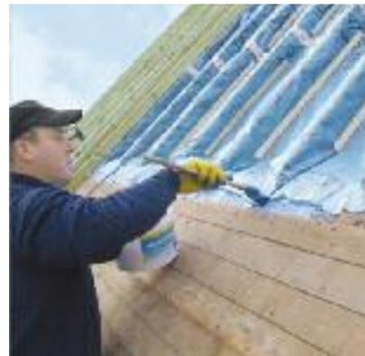
Die universell einsetzbare Reinacrylat-Dispersion Delta-Liquixx lässt sich einfach mit dem Pinsel verarbeiten und dichtet auch schwierige oder schwer zugängliche Details sicher ab
