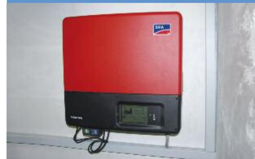
Der Wechselrichter wandelt den erzeugten Gleichstrom in Wechselstrom um
