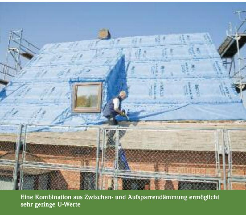
Eine Kombination aus Zwischen- und Aufsparrendämmung ermöglicht sehr geringe U-Werte
