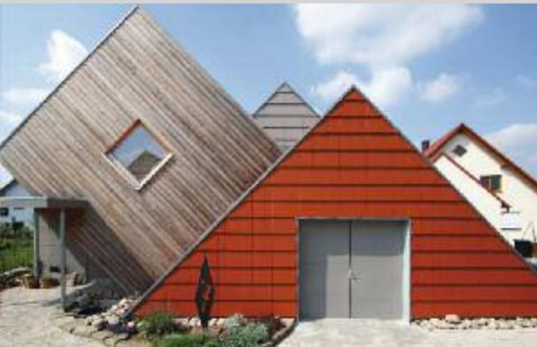
Der Kern der Wand besteht bei Holzhäusern dieser Art aus einem Ständerwerk aus Konstruktionsvollholz und einer Wärmedämmung aus Mineralwolle oder flexiblen Holzfaser-Dämmstoffen
