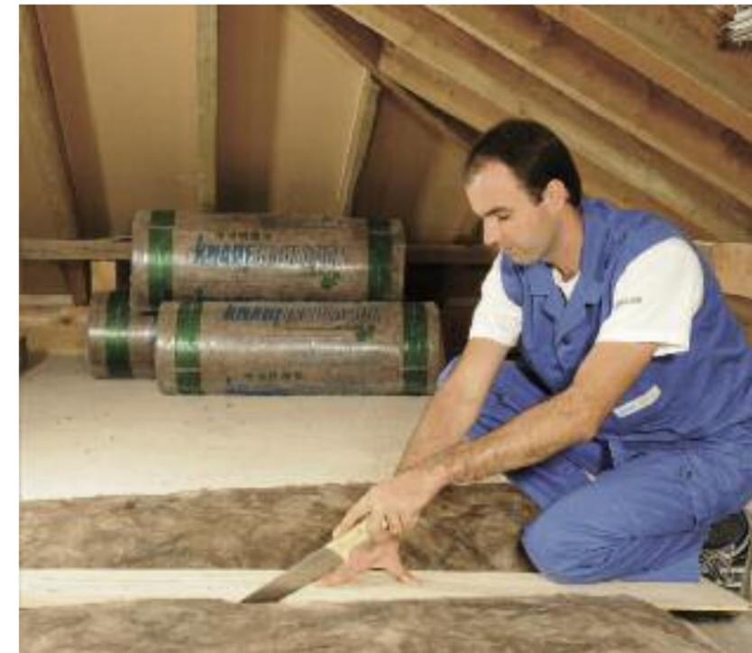
Glaswolle überzeugt durch besonders hohe Dämmwerte und kann relativ leicht verarbeitet werden
