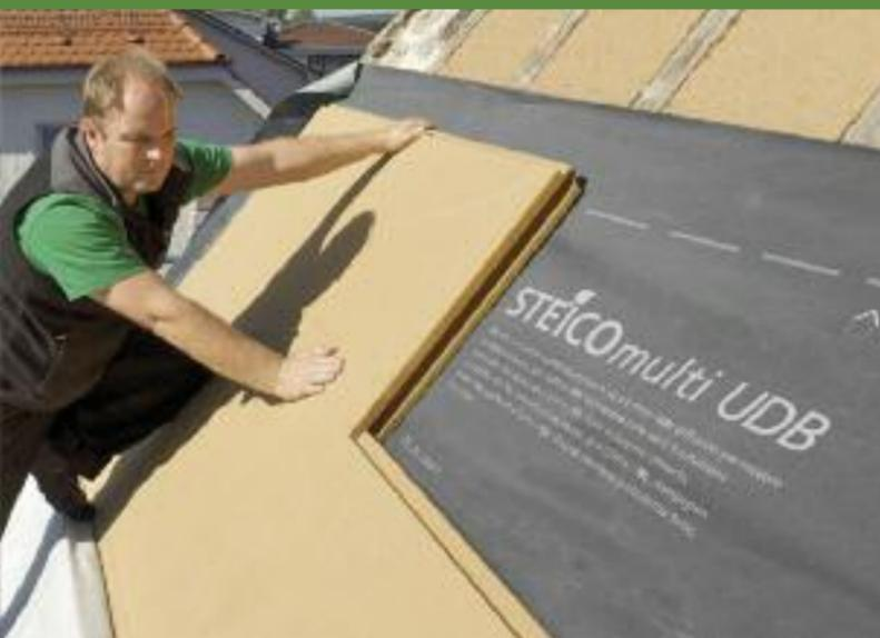
Eine zusätzliche Dämmung bietet die feste Dämmplatte aus umweltschonenden Holzfasern
